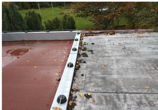
foto /4/ Pohled na dělicí atiku mezi střechou trafostanice a střechou letních šaten
